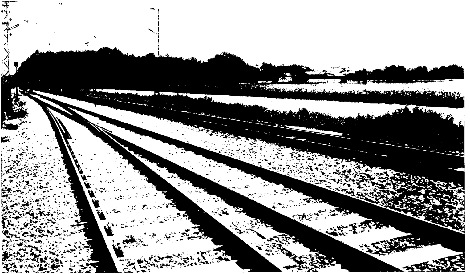
Figure 11. Appareil de voie monté sur des traverses en béton.
