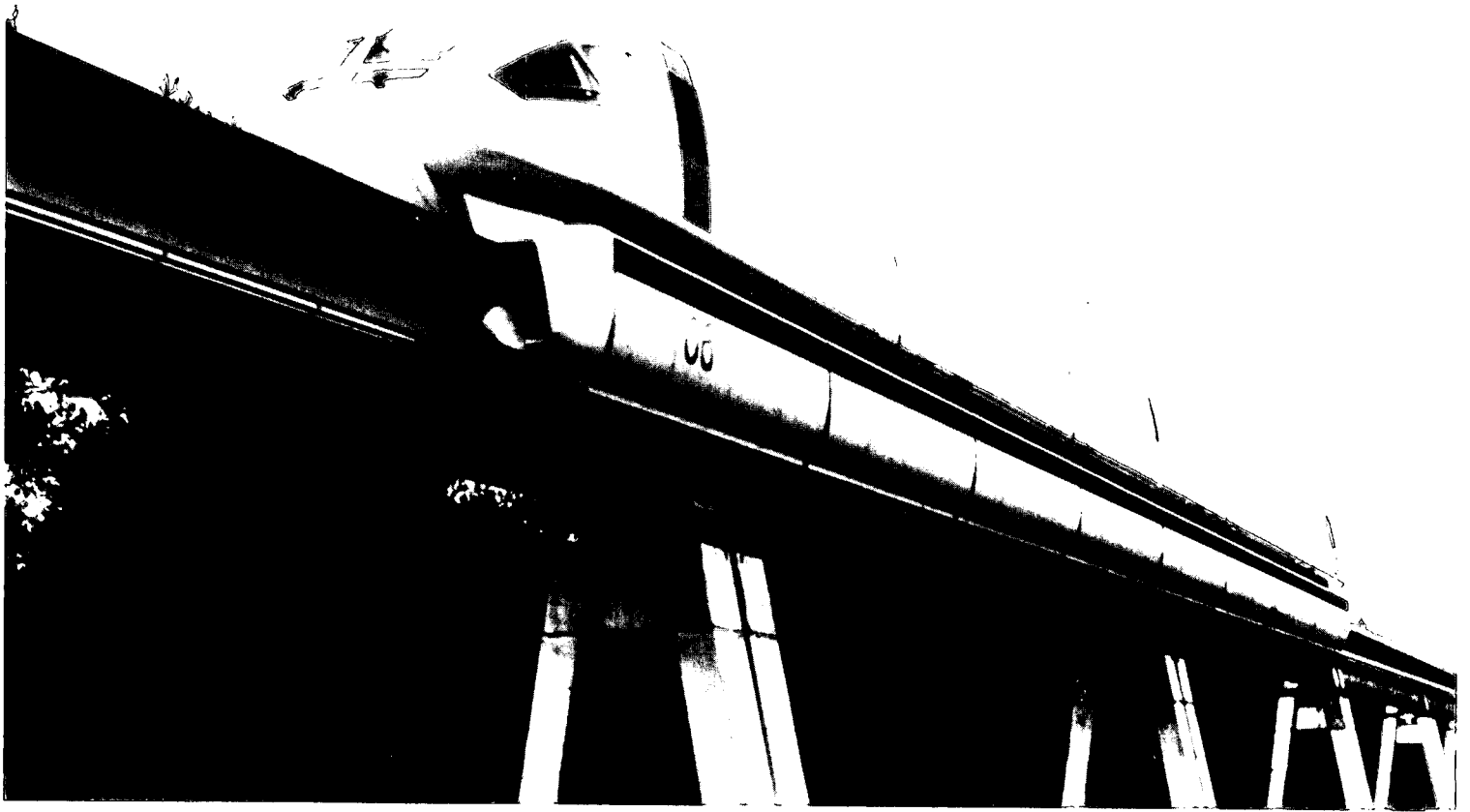
Figure 16. Installation d'essai du système à sustentation magnétique TVE.
