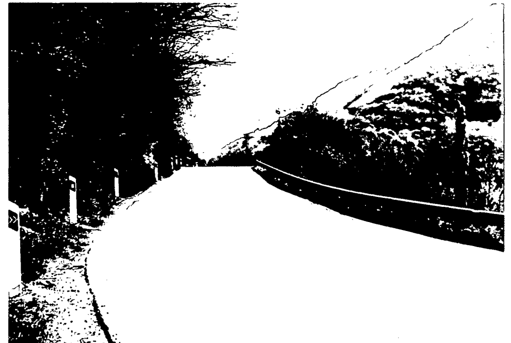
Virage dangereux en remblais
