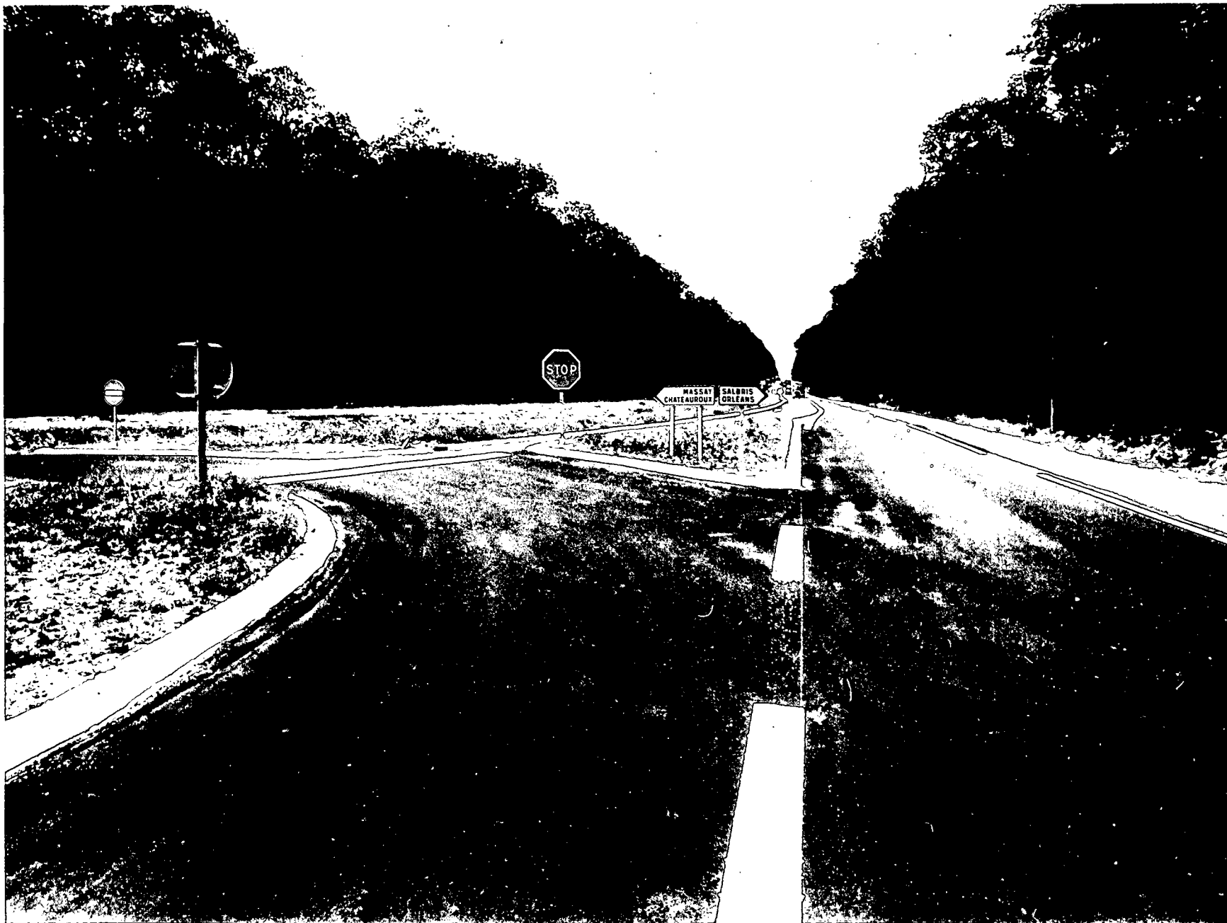
Carrefour aménagé sur la RN 20
