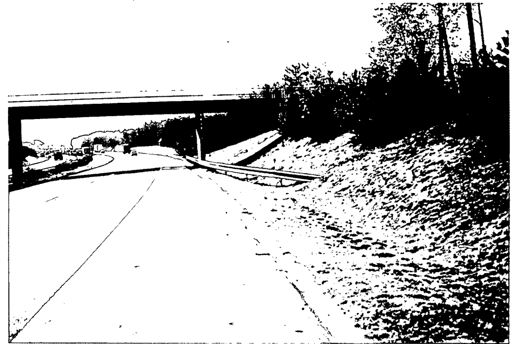
Isolément de pile de passage supérieur
