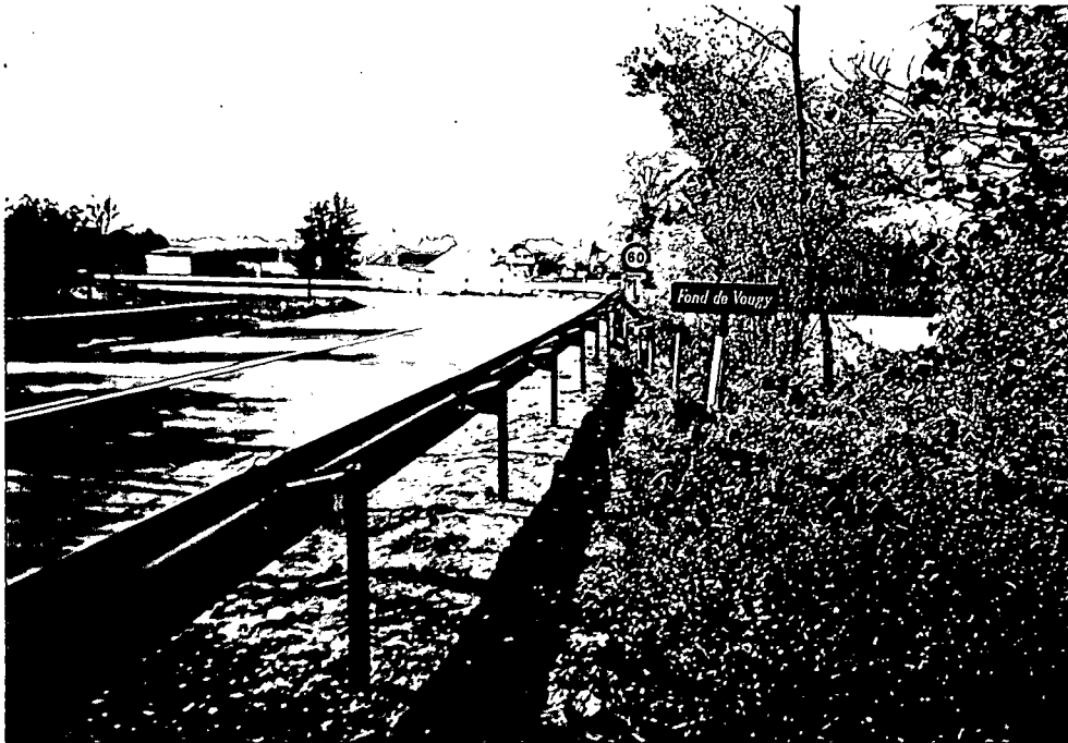
Virage dangereux surplombant un cours d'eau
