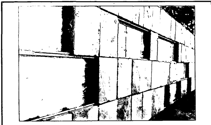
L'écran absorbant implanté à CAEN. Les plaques d'absorbant sont posées sur un bardage acier....
