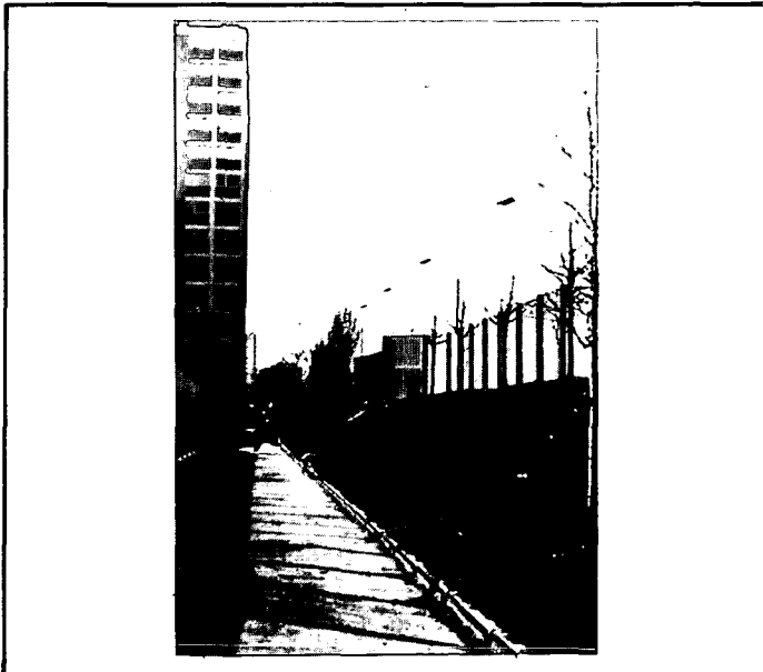
Chemin piéton et aménagements derrière l'écran implanté sur le périphérique Nord de PARIS.
