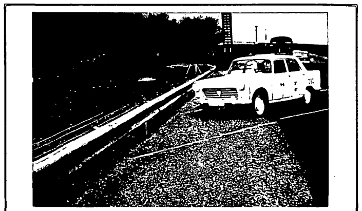
Glissière de sécurité.
