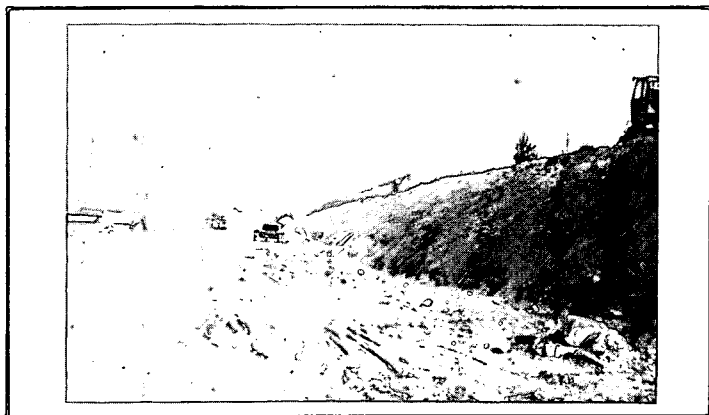
Butte en travaux le long de l'autoroute A86, dans la traversée de la commune de GENNEVILLIERS.
