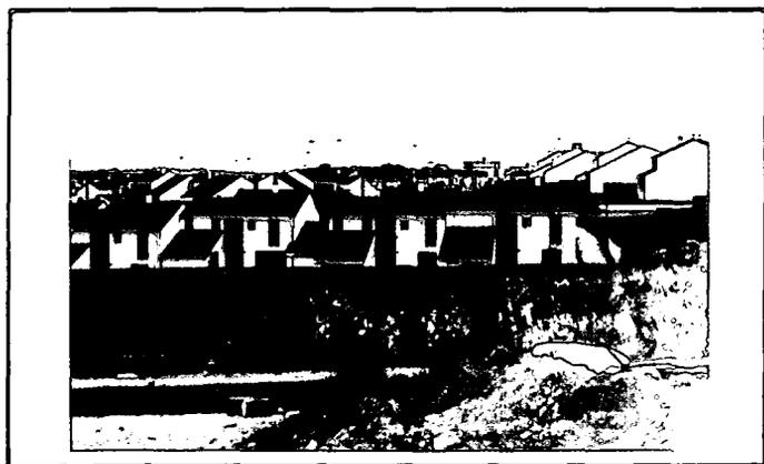
Protection par butte de terre d'un ensemble pavillonnaire implanté à proximité de la desserte ferrée de Cergy-Pontoise (la protection est ici en cours de réalisation).
