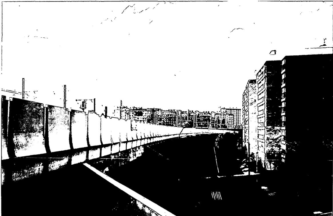
Protection latérale sur le remblai de la ligne N° 13 à Malakoff, réalisée par la R.A.T.P.
