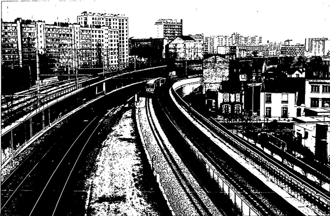
*Traversée de la commune de Malakoff par un ensemble ferré. A gauche, à proximité d'une ligne SNCF, le mur de soutènement a été revêtu de matériau absorbant (mousse d'argile).*
