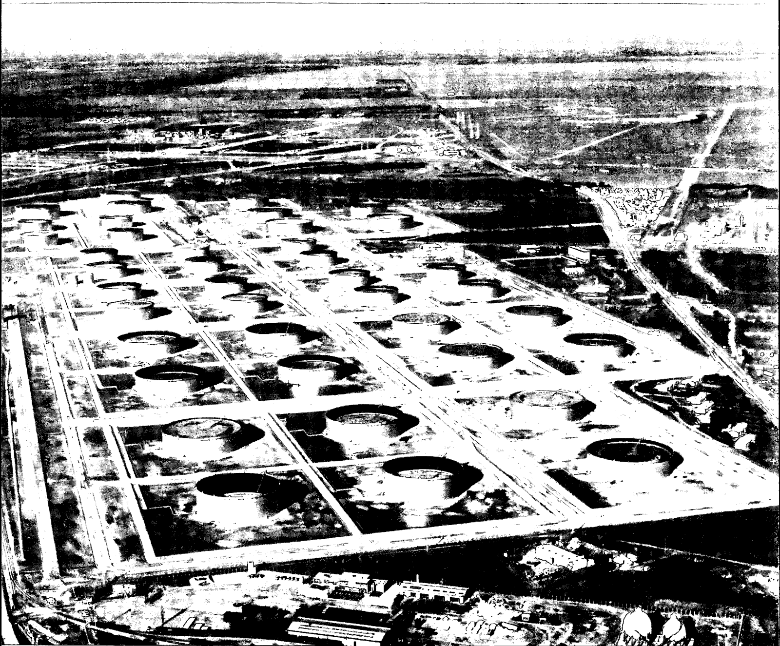
Ci-dessus : Le parc de stockage du Pipe-Line Sud-Européen à Fos. Ci-contre : Le départ du Pipe-Line Sud-Européen avec les tubes de 40 pouces. — Photo Gautschi et Louvel, Martigues.
