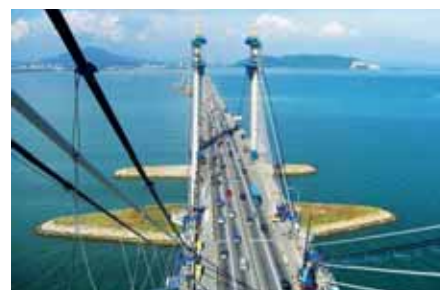
Malaisie — Pont de Penang
