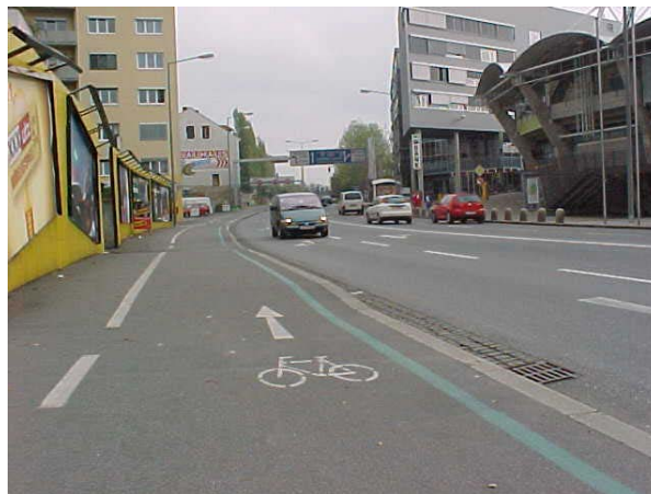
Graz : pénétrante depuis l'autoroute à la hauteur du Stade Arnold-Schwarzengegger et site d'un futur parking de rabattement
