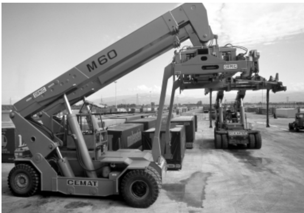
Grue mobile du constructeur Ormig, utilisée par Cemat sur le chantier de Verona Quadrante Europa
