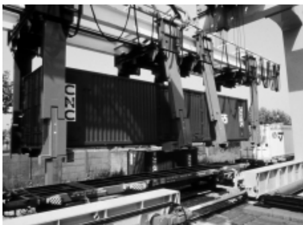
Le chantier de transbordement central "Commutor" à Paris (Photo SNCF)
