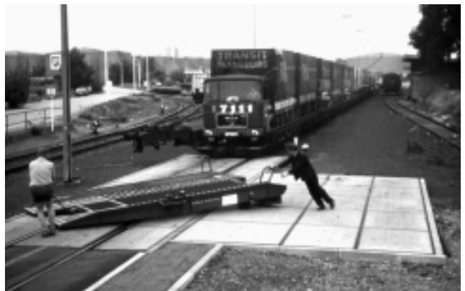
Route Roulante en 1984 dans le chantier de transbordement "Mainz Gustavburg" - une voie encastrée avec une rampe d'accès
