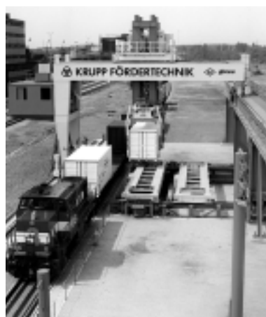
Le chantier de Krupp à Duisbourg conçu pour un transbordement rapide
