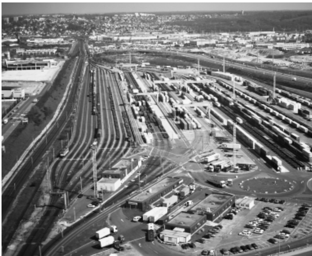
Le chantier de transbordement de Paris-Valenton, en service depuis 1985
