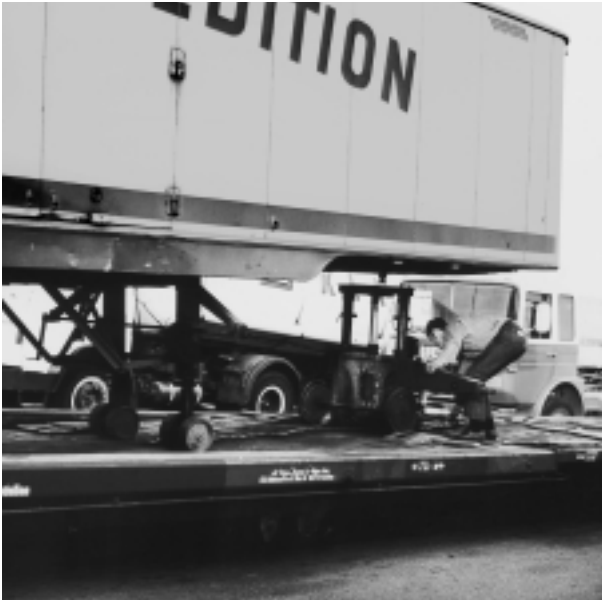
A Hambourg, une semi-remorque est fixée sur un wagon Wippen à l'aide d'une sellette mobile
