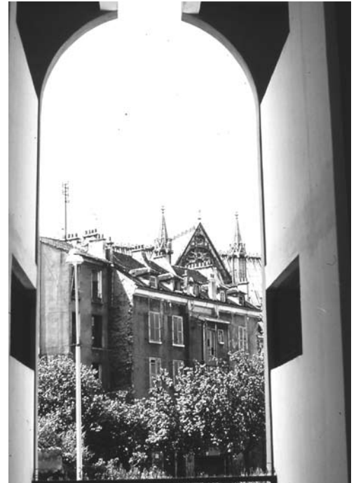
Saint-Denis (93), rénovation quartier Saint-Denis Basilique
