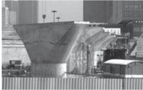
Construction des 12 méga-piliers sur lesquels repose le cube. MEDAD/SG/SIC, oct. 86, phot. B Suard
