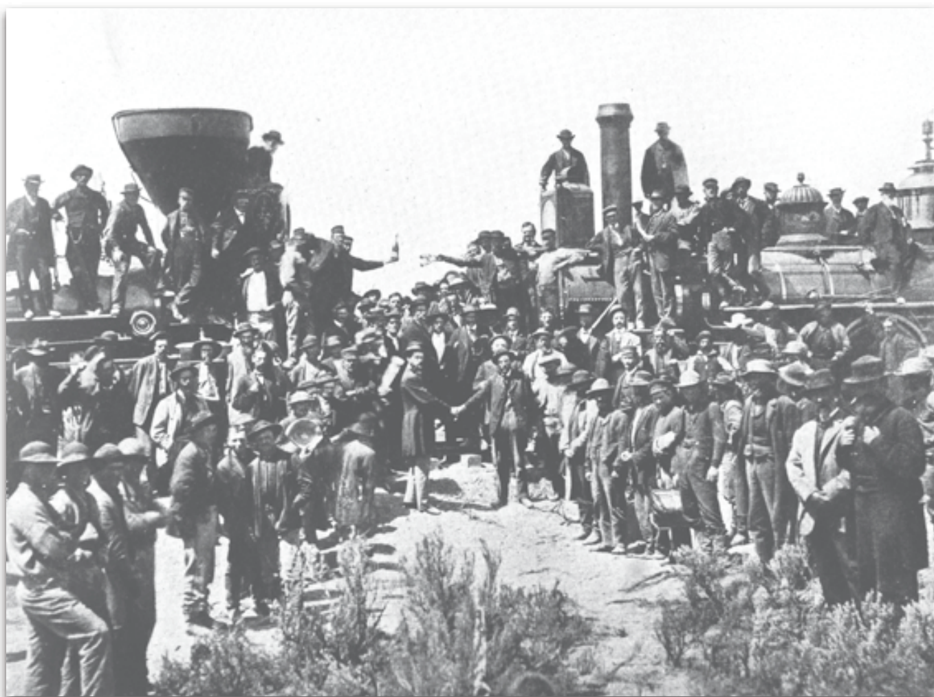
Pose du rivet d'or et première jonction de l'Atlantique au Pacifique par la voie ferrée à Promontory (Utah), le 10 mai 1869 (document de l'Union Pacific Railroad). in Les chemins de fer , op. cit. p.119 ; MEDAD, fonds anciens du CRDAJ; phot. B.Suard
