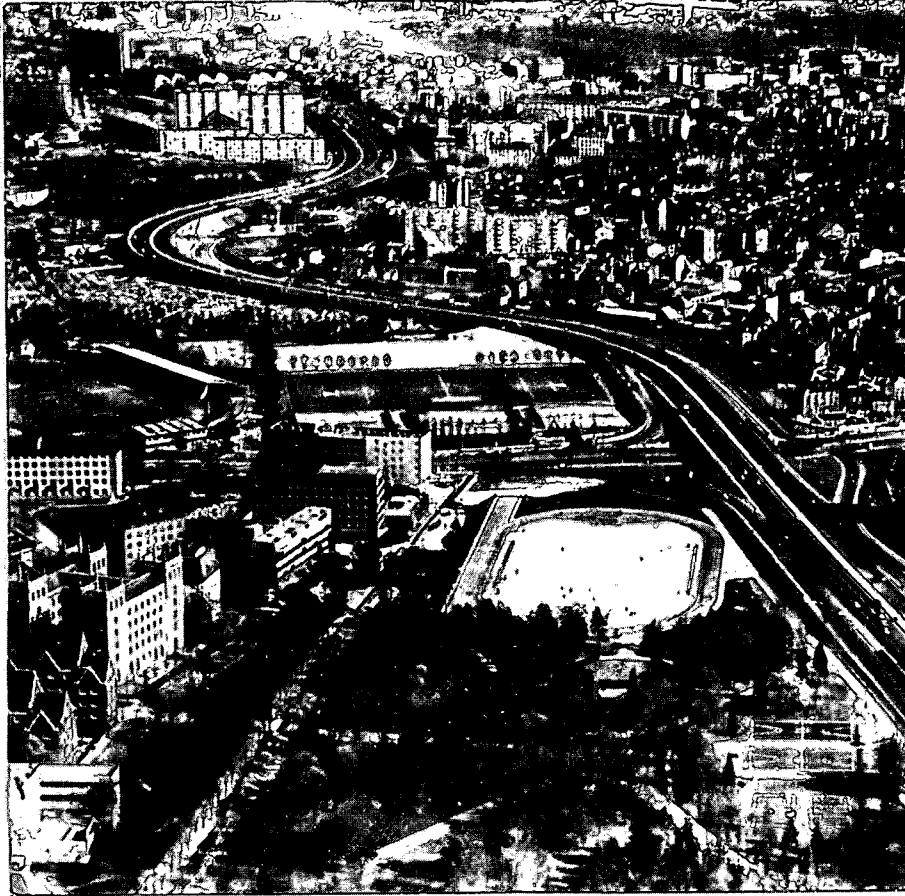
Vue aérienne « Durandaud »
