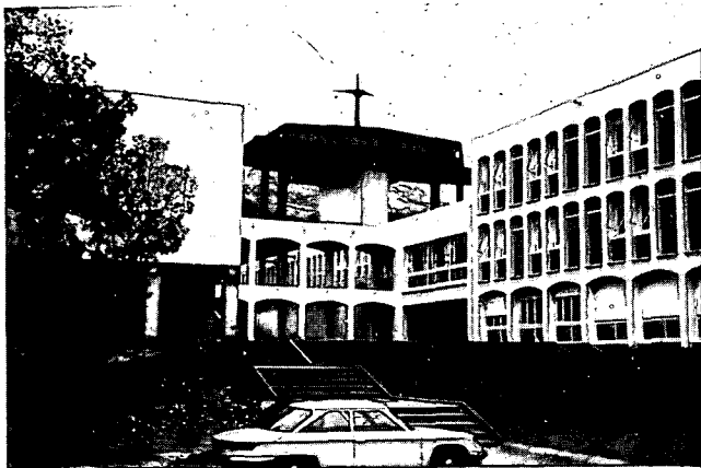
École Nationale de la Marine Marchande de Marseille Accès au grand hall et passerelle de navigation
