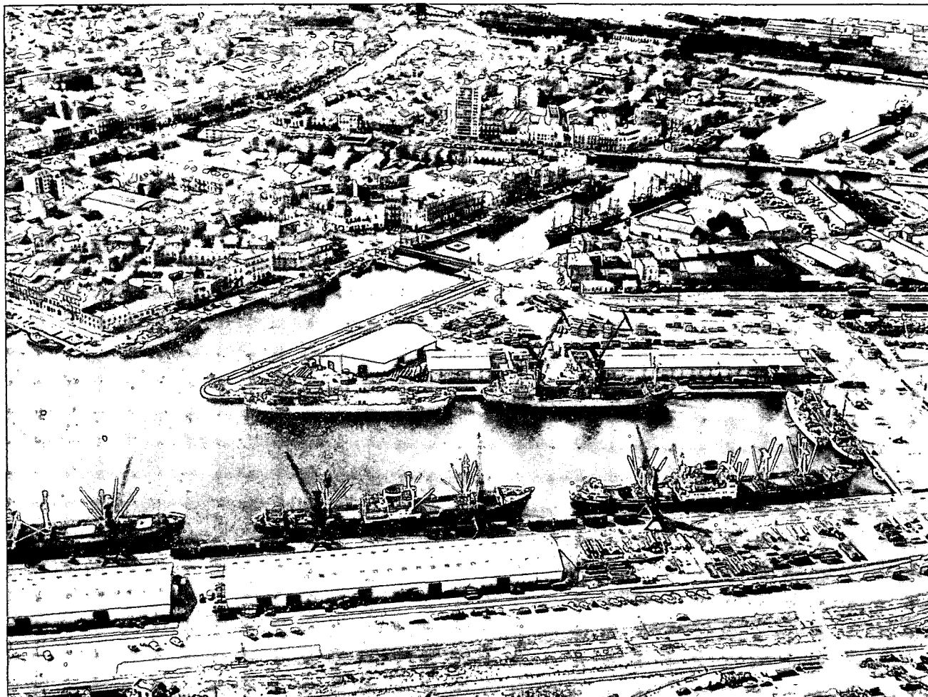
Vue générale du port de Sète
