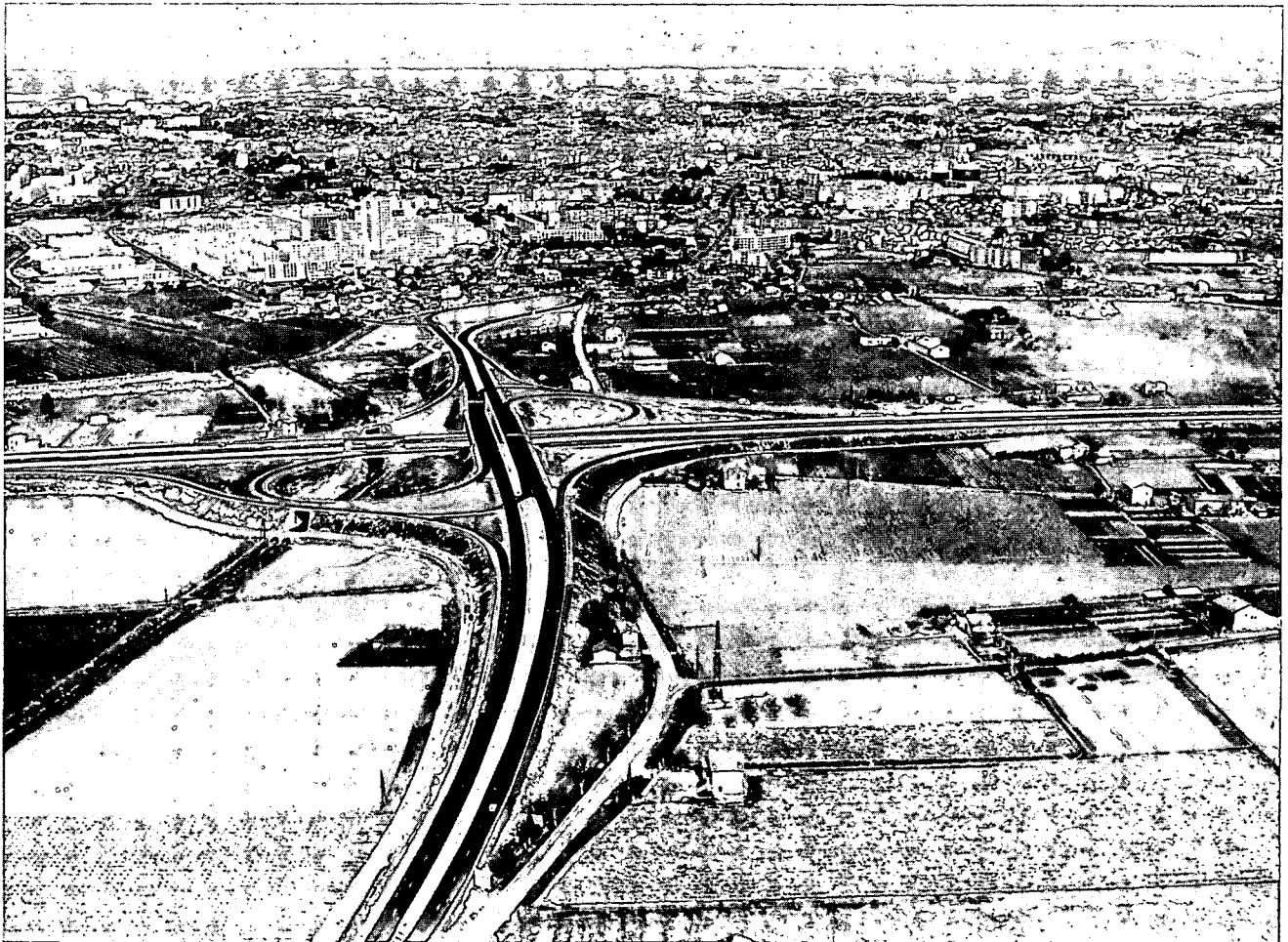
Au sud de Montpellier, échangeur de l'autoroute A9 avec RN 586
