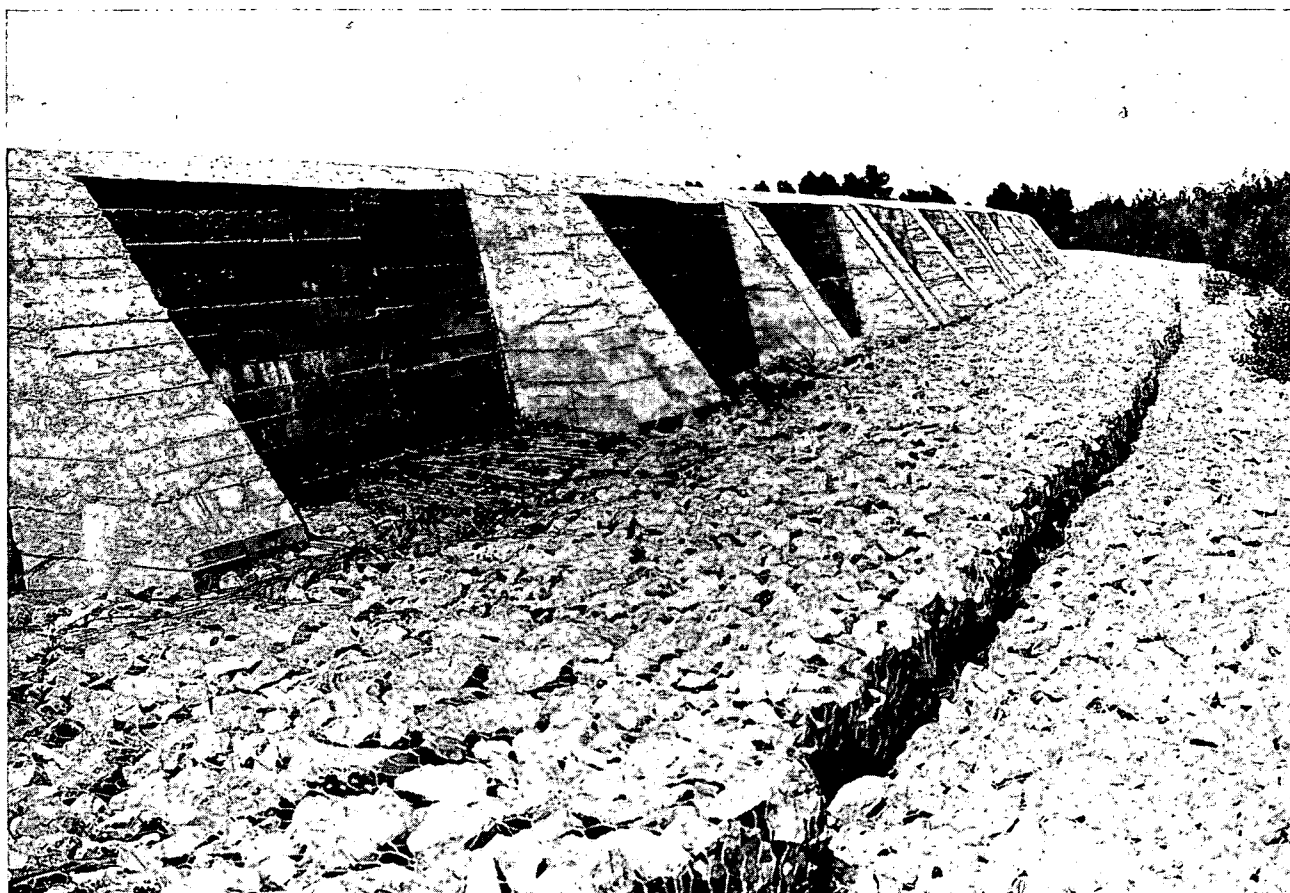
Digue submersible sur la Têt à Sainte-Marie (P.-O.) à contreforts et plage parasouille arrière
