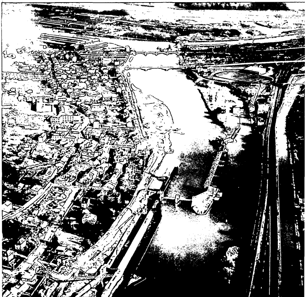
Barrage-écluse de Frouard.
