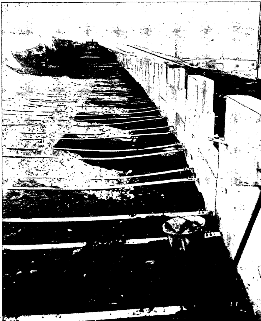
Mur de Montreuil.
