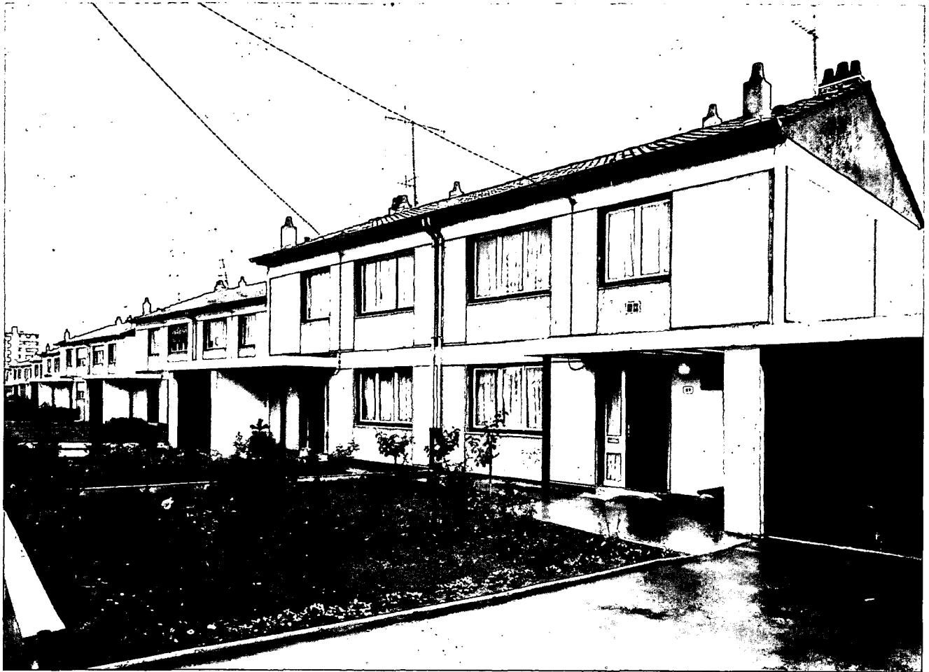
Constructions industrialisées (Entreprise Camus-Dietsch)
