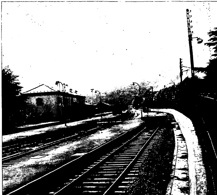
Quai de la gare de Bourg-Saint-Maurice
