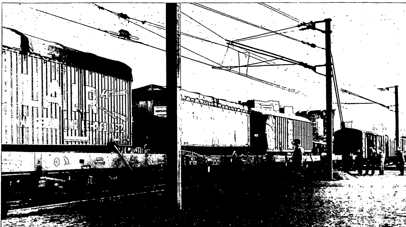
Chargement de semi-remorques routières sur wagons « Kangourou »
