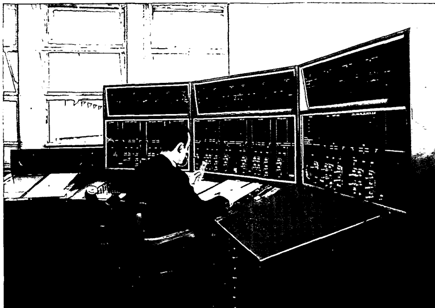
Commande centralisée de la circulation de la ligne de Dole à Vallorbe installée à Dijon
