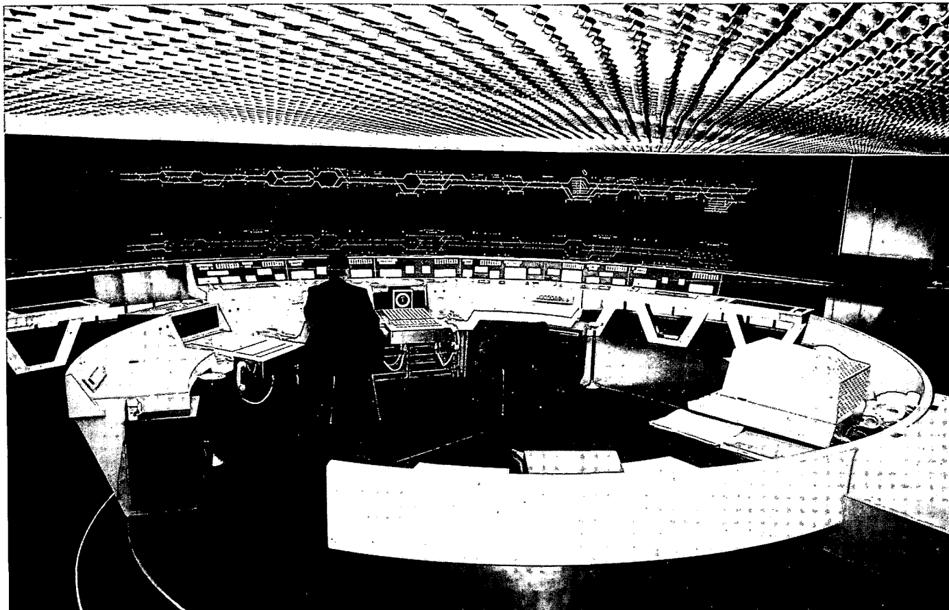
Poste de commande centralisé du métro régional (lignes de Boissy-Saint-Léger et de Saint-Germain-en-Laye)
