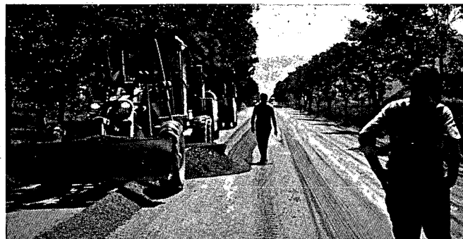
Chantier de renforcement coordonné Application d'une couche de base en grave-laitier
