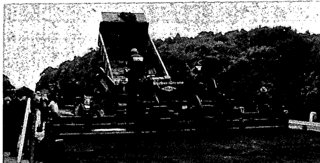
Renforcement de la chaussée de l'autoroute de l'Ouest dans le sens Province - Paris par application en grande largeur (plus de 10 m) d'un revêtement de 25 cm d'épaisseur en enrobé bitumineux.
