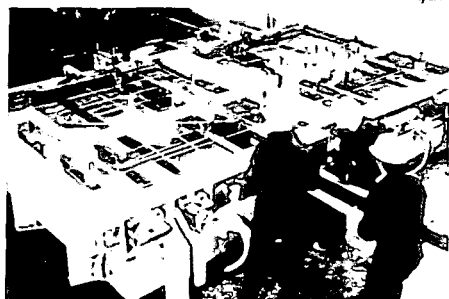
Mise en place des noyaux pour ventilation d'un mur technique
