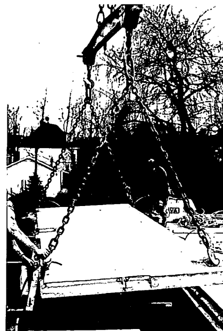
Manutention d'une dalle sur chantier
