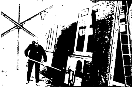
Nettoyage d'une façade
