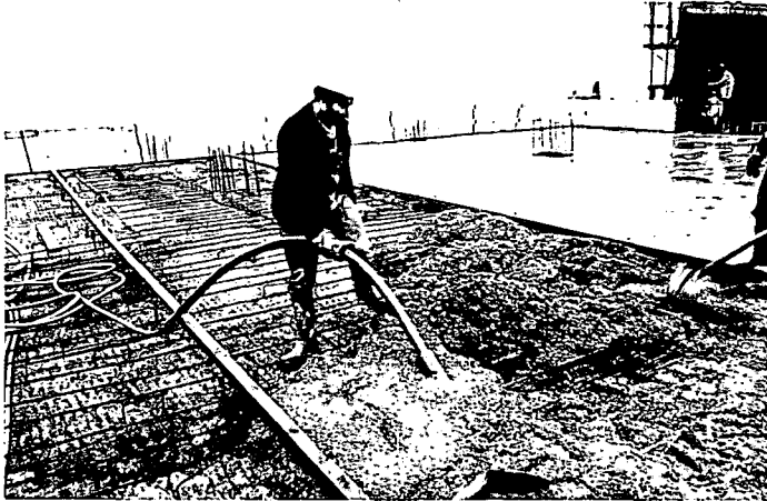
Vibration du béton léger sur le chantier d'Évry
