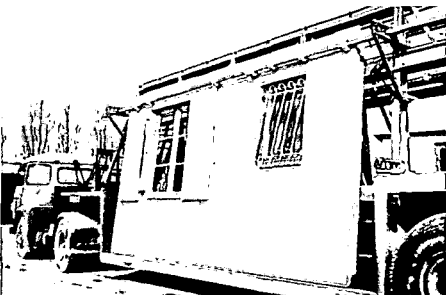
Transport d'un panneau de façade pavillon
