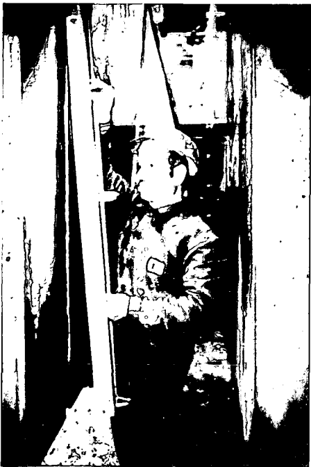
Mise en place d'un coffrage latéral dans une alvéole de batterie verticale
