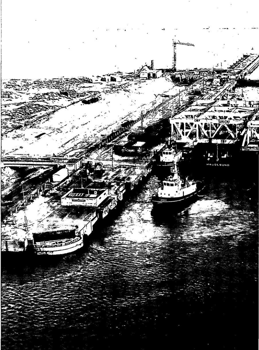
L'écluse Charles-de-Gaulle et les travaux de la station de pompage à gauche de l'écluse.
