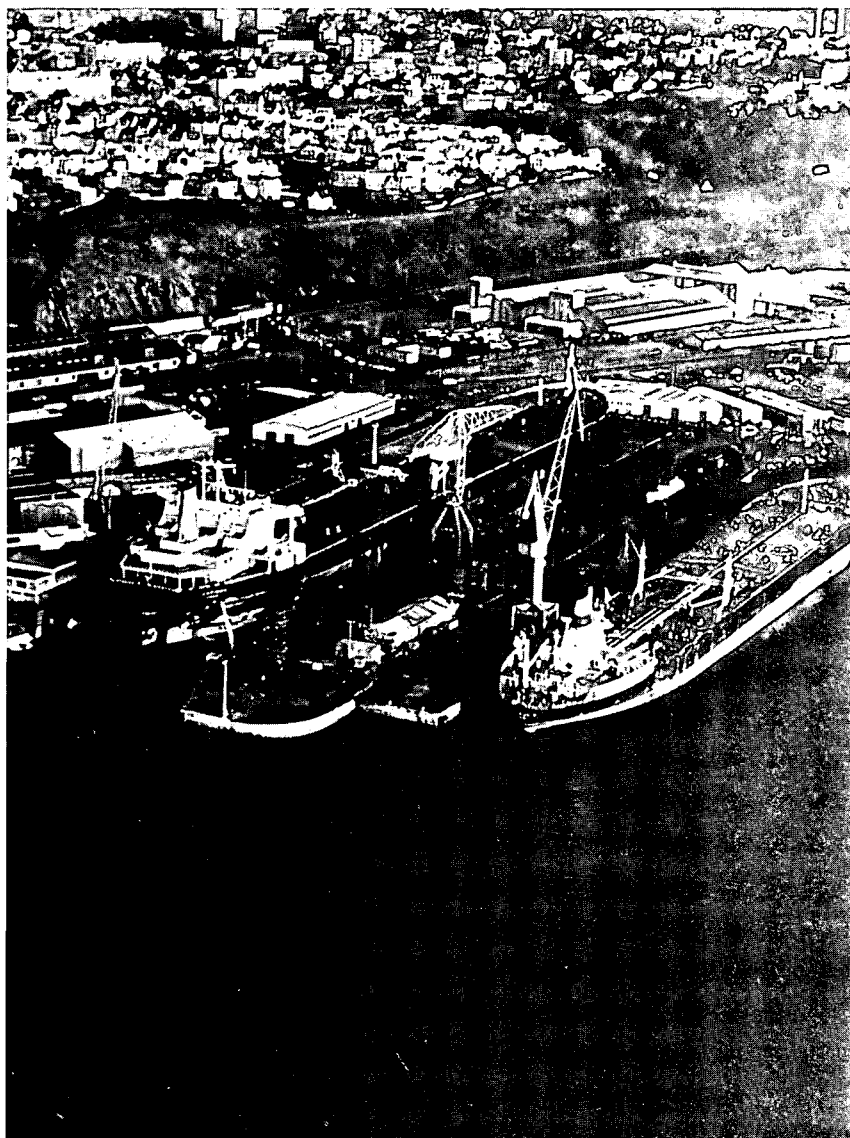
Vue sur les ouvrages de la réparation navale (quai 1, forme 2 et quai 2). Le pétrolier vient de rentrer en forme, le bateau-porte n'est pas encore en position de fermeture.
