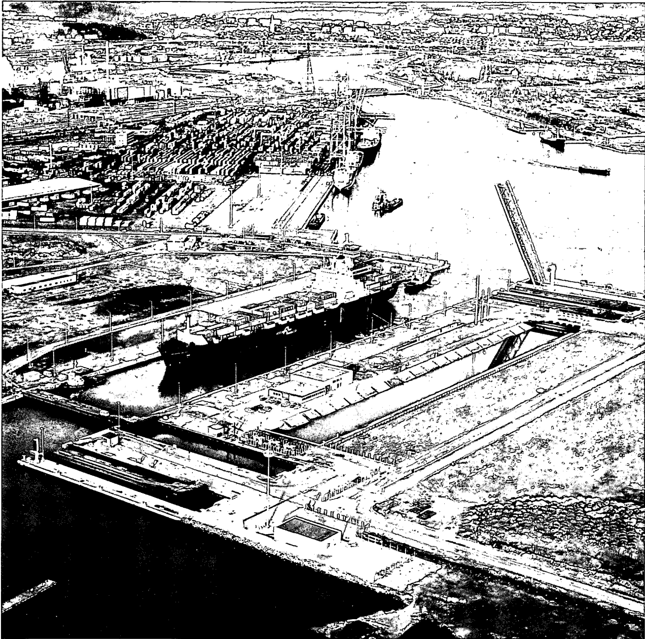
Port du Havre L'écluse François-1 er avec un porte-conteneurs en cours de sasement, le terminal à conteneurs du quai de l'Europe à l'arrière-plan
