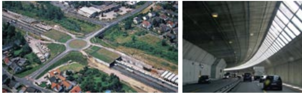
Figure 11. Amélioration du passage par le biais de mesures de protection sonore
