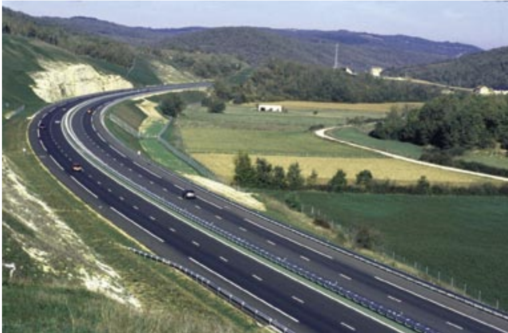
Figure 14. Tracé de l'autoroute A20 dans la Combe « de la Dame » [ASF]
