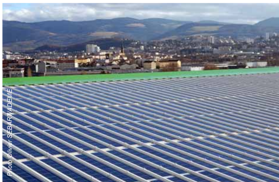
Installation solaire photovoltaïque sur le stade Geoffroy-Guichard de la ville de Saint-Étienne
