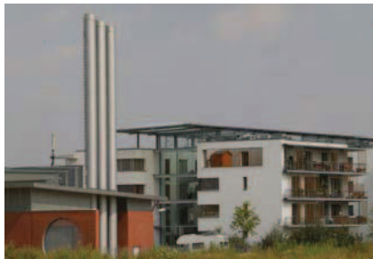
FIGURE 10 : CENTRALE DE COGÉNÉRATION DÉCENTRALISÉE (ARTICLE : L'ÉCO-QUARTIER EXEMPLAIRE DE HANNOVRE-KRONSBURG (KARIN RUMMING))
