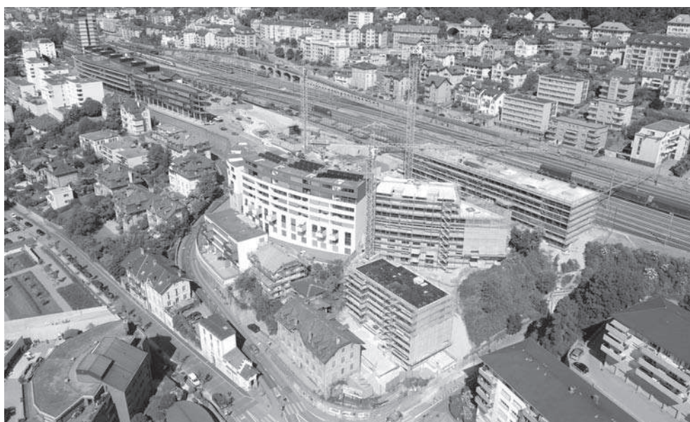
FIGURE 3 : VUE AÉRIENNE DU PROJET ECOPARC EN COURS DE RÉALISATION (PHOTO E. BETTINELLI, JUIN 2006)
