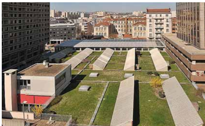
Toit végétalisé des halles, Lyon 3 e arrondissement.
