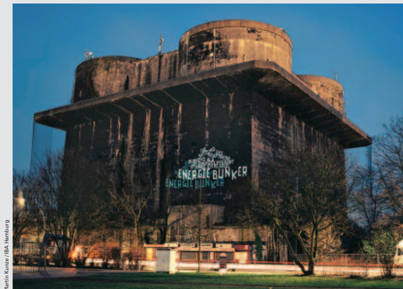
Bunker converti en station d'énergie solaire à Wilhelmsburg.
