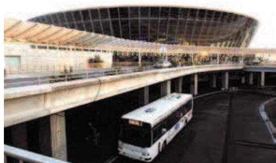
Aéroport de Nice-Côte-d'Azur, 2003. L'extension T2 de l'aérogare passagers. Architecte : Paul Andreu. ©DGAC/STAC/Véronique Paul
