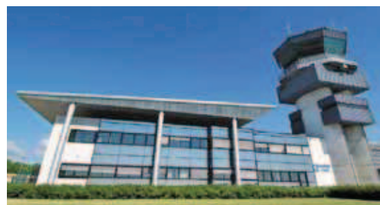
Aéroport de Limoges-Bellegarde. Bloc technique et tour de contrôle, côté piste, 2006. ©DGAC/DAC Sud/Gabrielle Voinot
