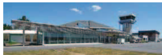
Aéroport de Rodez-Marcillac. Aérogare passagers et tour de contrôle, 2006. ©DGAC/DAC Sud/Gabrielle Voinot
