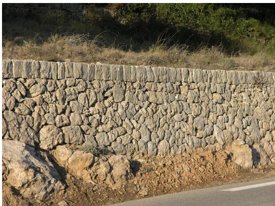
Ouvrage en pierre sèche ou faiblement maçonné - photo C. Cornu, CMA Vaucluse
