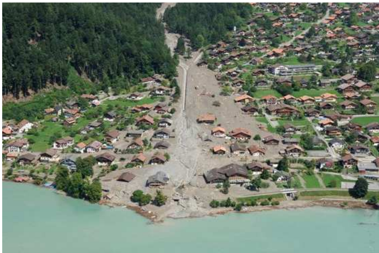
Laves torrentielles à Brienz en Suisse en 2005 - Source © Forces aériennes suisses
