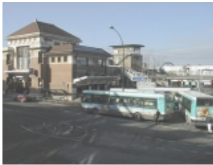
2 Station de bus et gare RATP
