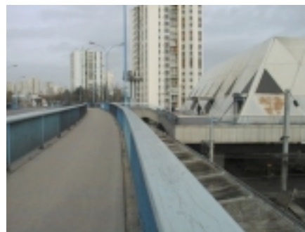
3 L'accès principal par le pont
