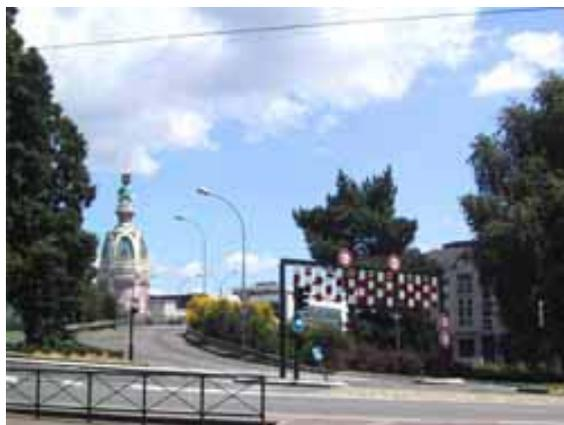
*La rampe de l'autopont franchit les voies ferrées avant de rejoindre la pénétrante sud. On note le caractère routier de l'ensemble avec glissière de sécurité, anticamion, etc. (source :nantes44.com)*
