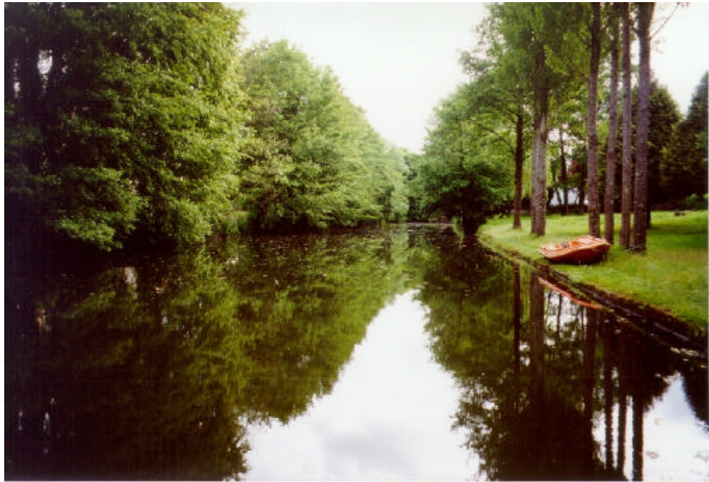
Figure 40 : St Joseph de Porterie : bassin de retenue des eaux pluviales
