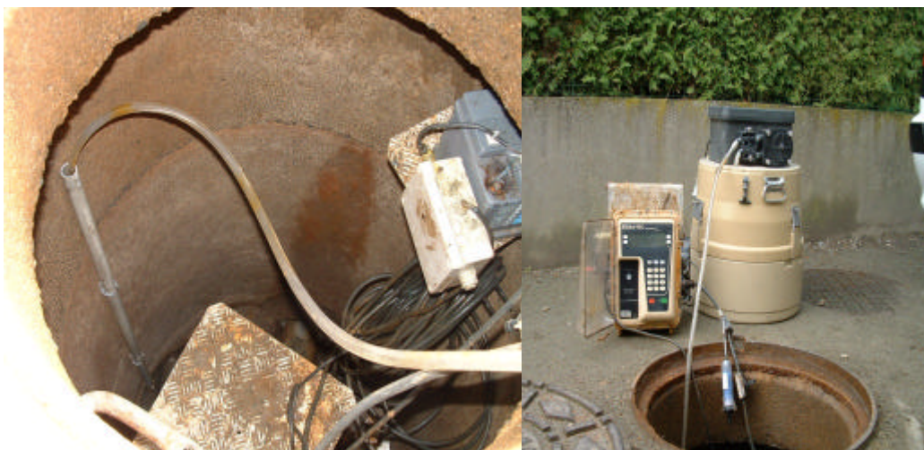
Figure 6 : installation du matériel de mesure dans le collecteur eaux usées
