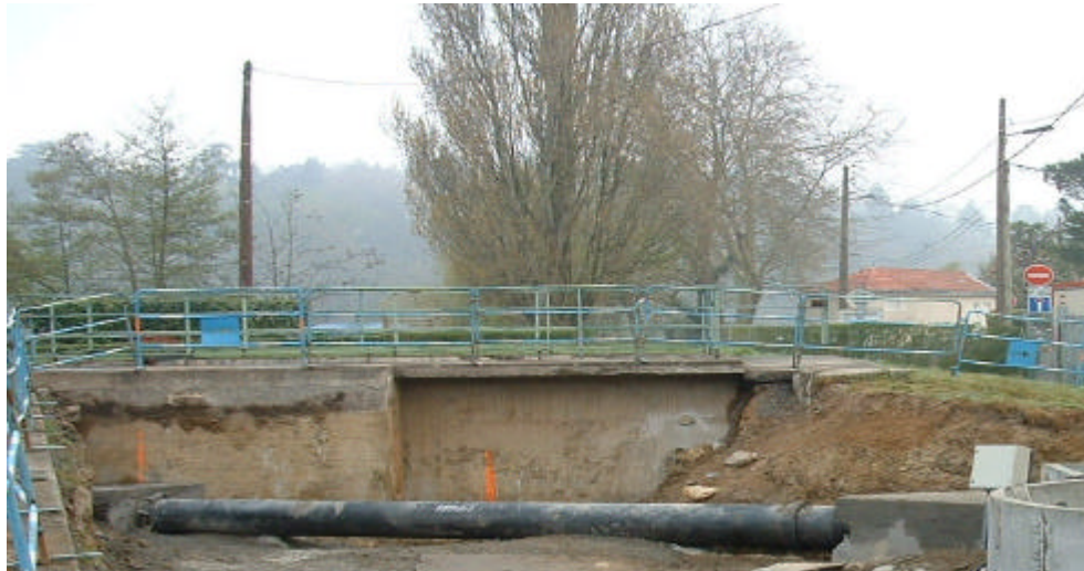
Figure 4 : Station de pompage de Port-la blanche pendant les travaux de transformation (début 2004)
