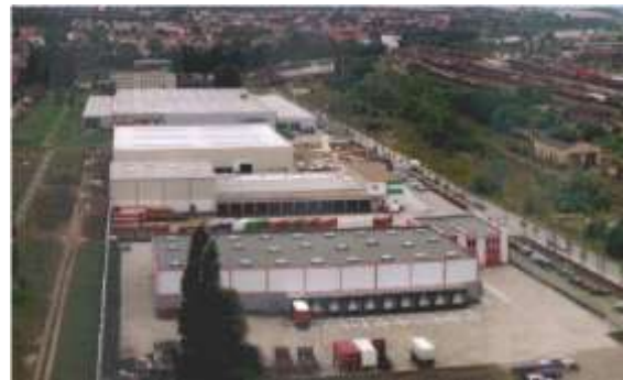
Vue de la ZA accueillant le centre logistique VW (Crédit photo : Volkswagen)
