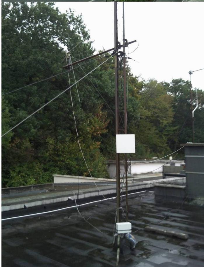
Antenne type slender montée sur un mât
