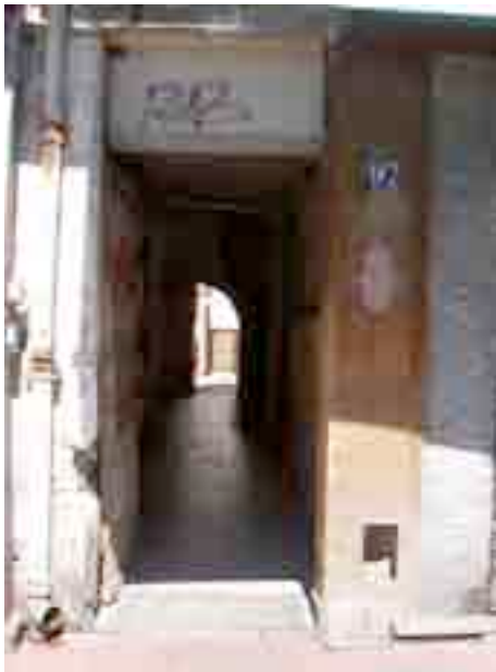
2003, habitat insalubre à Saint-Ouen, 97 rue des Rosiers (coll. privée)
