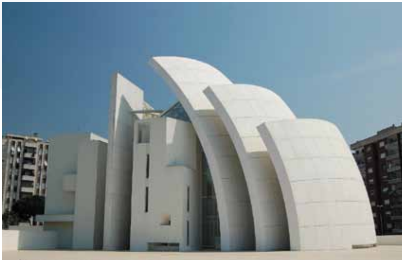
Église de la Miséricorde à Rome utilisant des matériaux de remédiation active, architecte Richard Meier © photo by alaninabox on Flickr.
