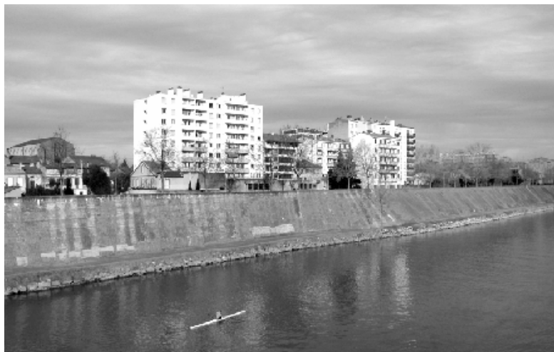
La digue de l'Avenue de Muret à Toulouse en rive gauche de la Garonne (fin des années 1950).
