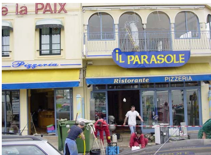
Figure 26 : Photo des travaux de réfection entrepris très rapidement dans un restaurant.
