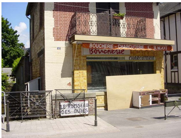
Figure 24 : Photo d'une boucherie-charcuterie fermée à cause des inondations. Touques (centre-bourg)
