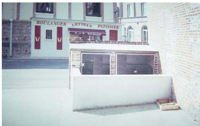
Photo prise en 2002 : arrière du bâtiment. Muret de protection d'un moteur réalisé suite a la crue de 2001
