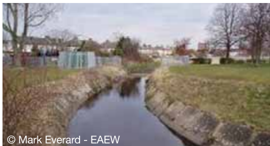
Figure 15 : Etat du Mayes Brook avant sa restauration : enserré dans un canal en béton et rendu inaccessible sur une grande partie de son linéaire par une clôture de sécurité
