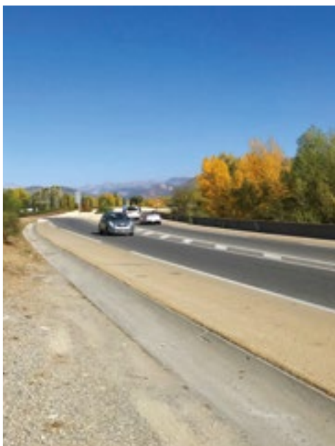
Aménagement de la desserte de Digne-les-Bains
