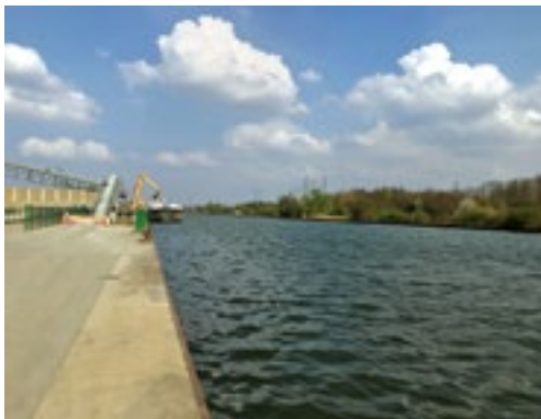
Dragage d'entretien sur le canal du Rhône au Rhin
