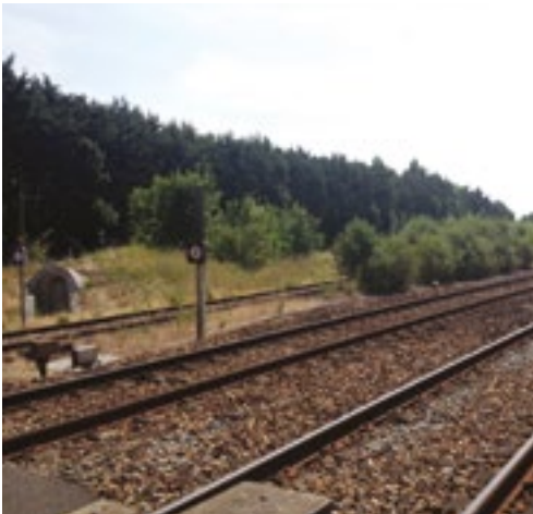
Électrification de l'axe ferroviaire Amiens - Abbeville - Rang-du-Fliers
