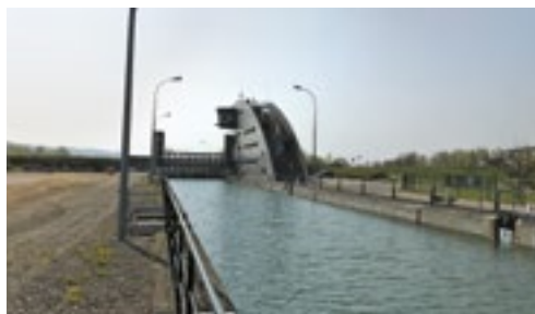
Dragage d'entretien sur le canal du Rhône au Rhin
