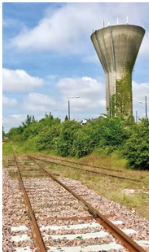
Ligne ferroviaire Orléans - Châteauneuf-sur-Loire
