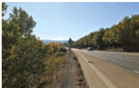
Aménagement de la desserte de Digne-les-Bains
