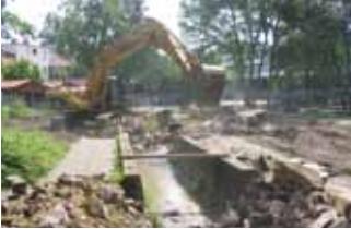
AVANT - Démolition du lit du ruisseau canalisé © Office for Environmental Protection, Energy and Mobility city of Offenbach am Main
