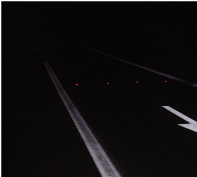
Figure 2.3 : Barrière lumineuse en fonctionnement
