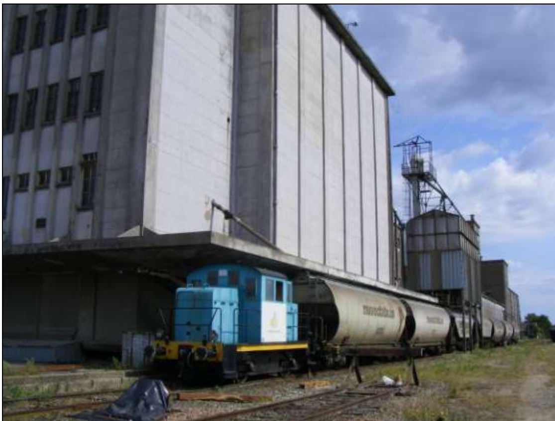
Figure 19 - Infrastructure terminale embranchée à un silo de céréales (à côté de Pithiviers)
