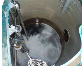
Figure 10: Pompage des lixiviats dans le site pour faire monter le niveau dans le poste de transfert
