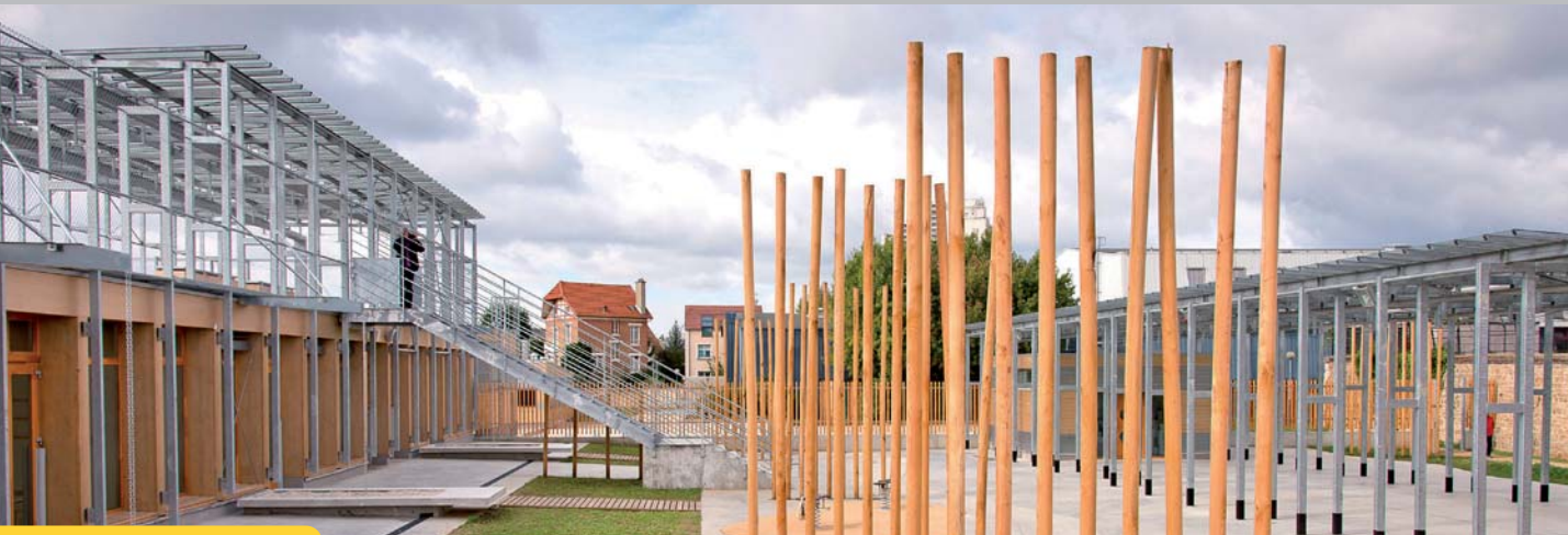
Ecole Louise Michel dans le quartier Fort d'Issy, premier établissement public construits en ossature bois et isolation en paille. Crédit ISSY MEDIA
