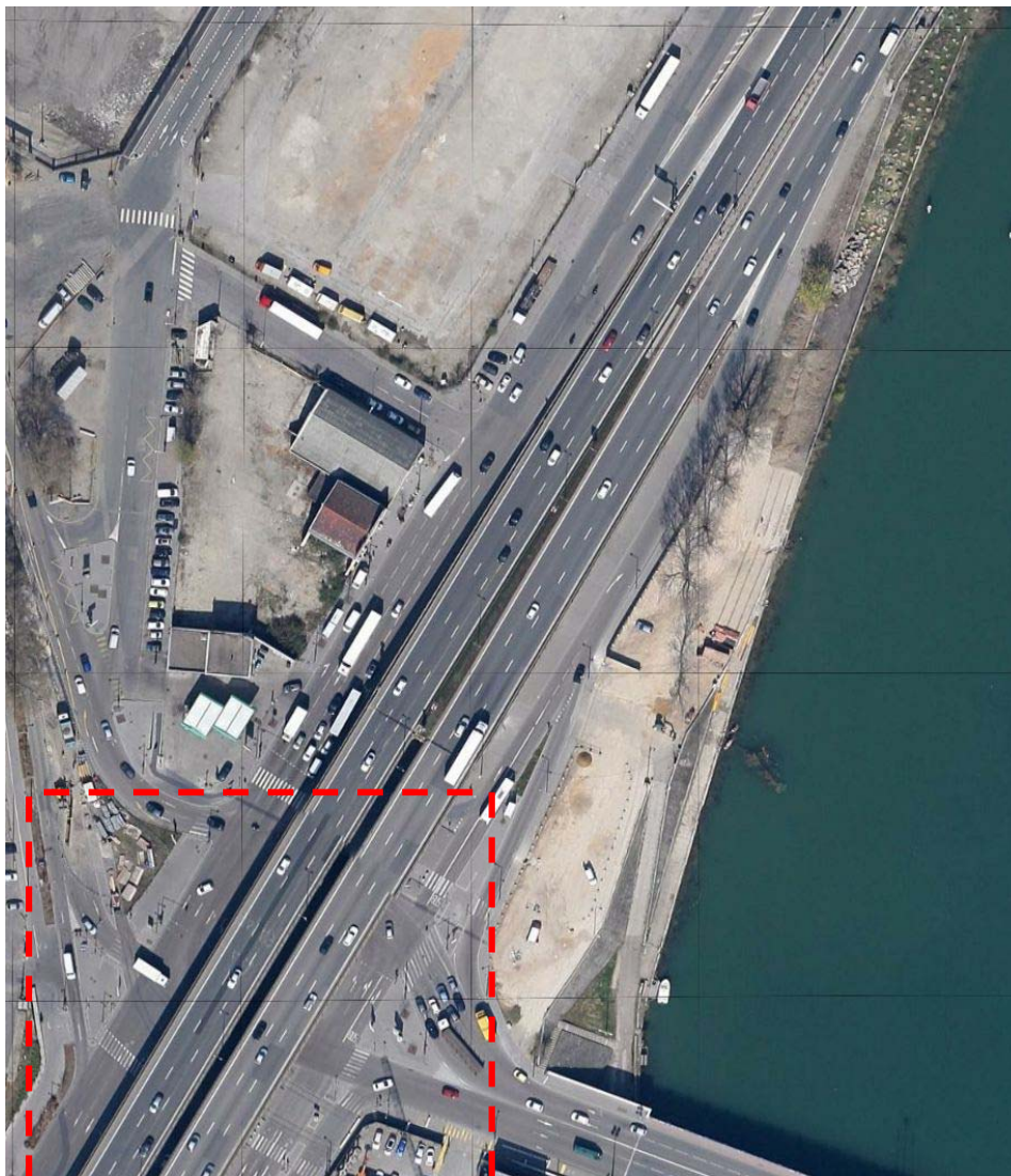
Figure 15 : Voie d'insertion au nord du pont Pasteur
