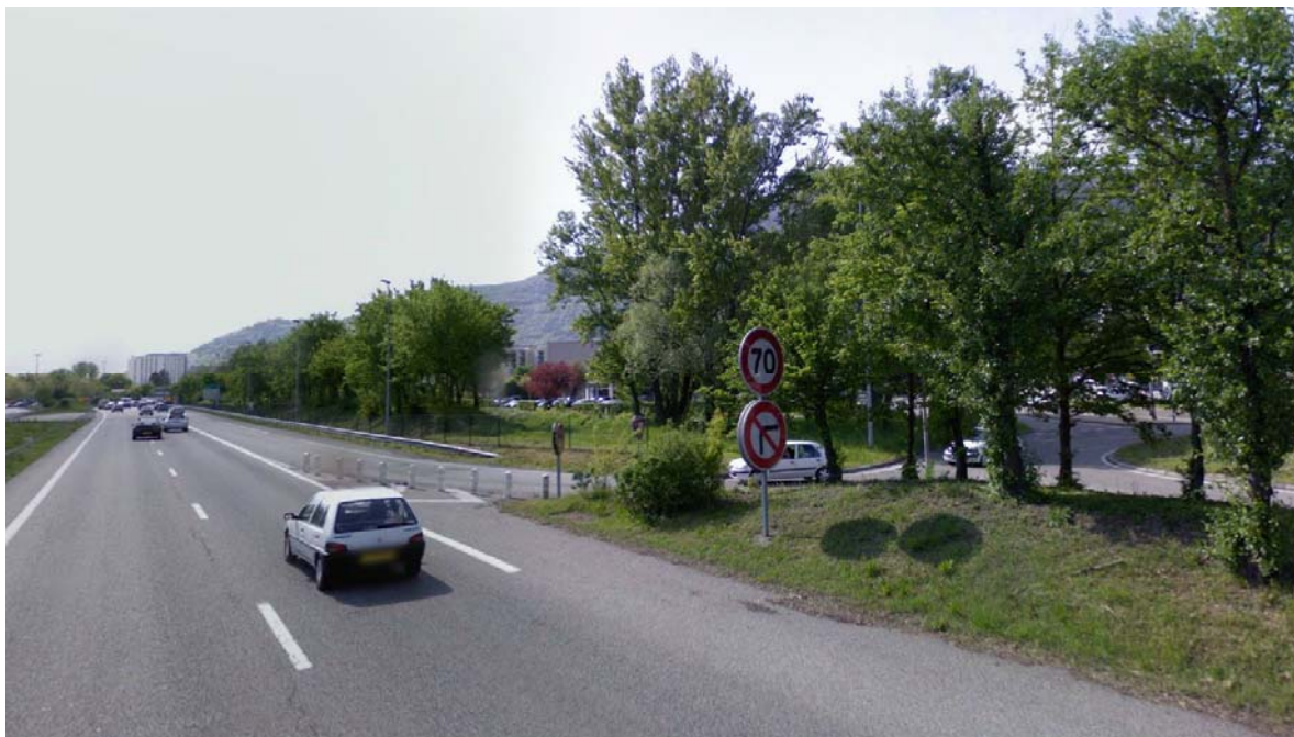
Photo 1 : Insertion d'une 3ème voie sur l'A41 à la hauteur du boulevard des Alpes
