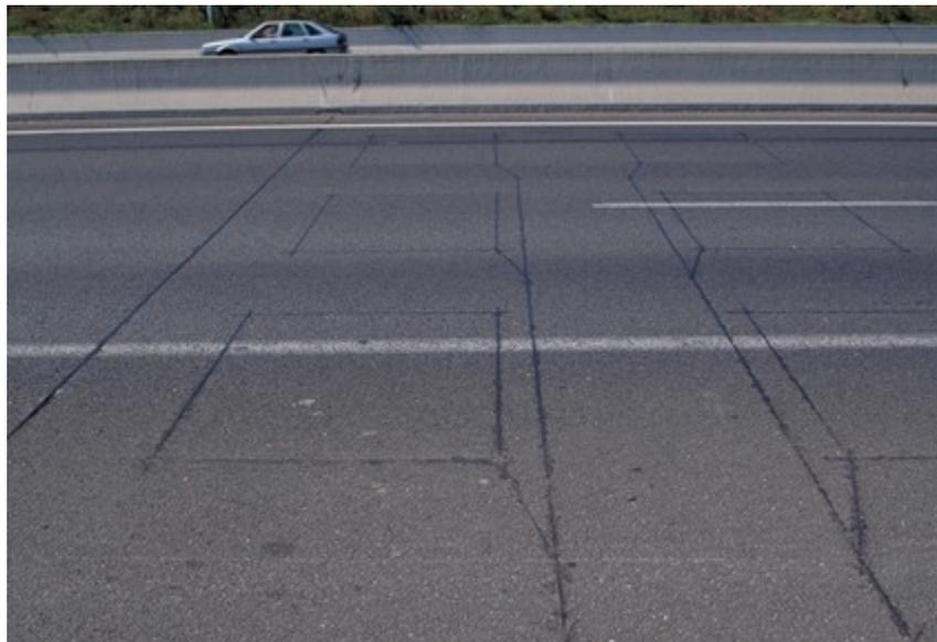
**Figure 6 : Les boucles électromagnétiques dans la chaussée (source MEDDE)**
